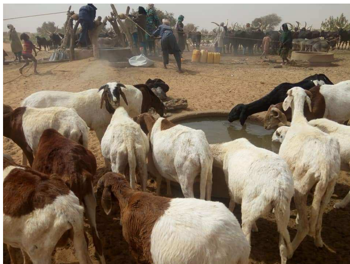
Le puits pastoral, situé à la lisière du village, avant les travaux
